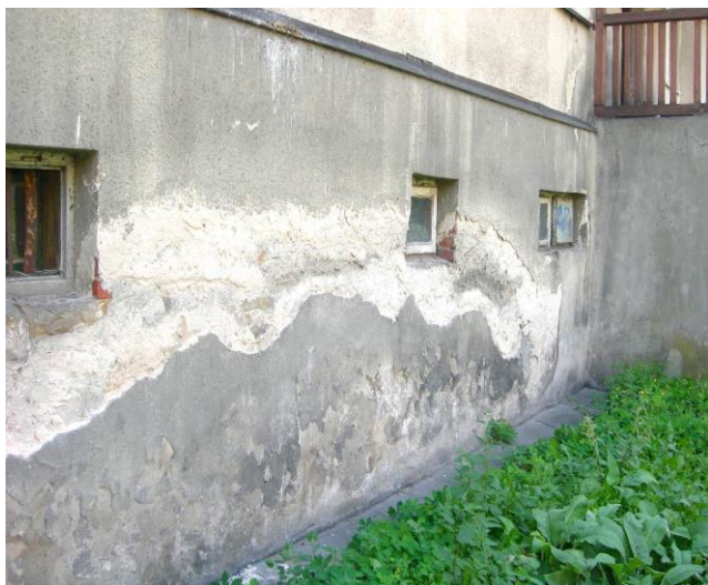
Zawilgocenie na wysokości ok. 2,20m
