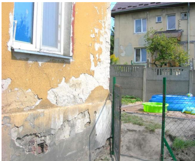
Zawilgocenie na wysokości ok. 1,40m
