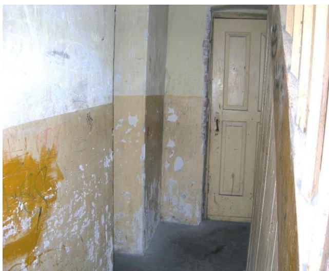
Zawilgocenie na wysokości ok. 2,30m
