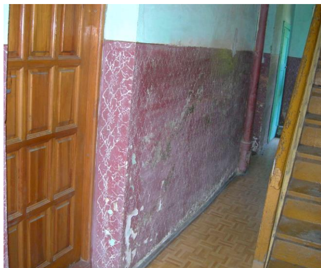
Zawilgocenie na wysokości 1,50m
