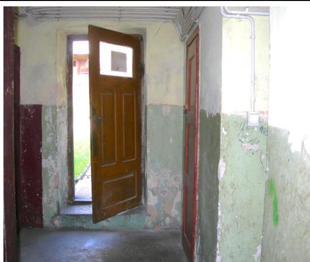
Zawilgocenie na wysokości 2,10m
