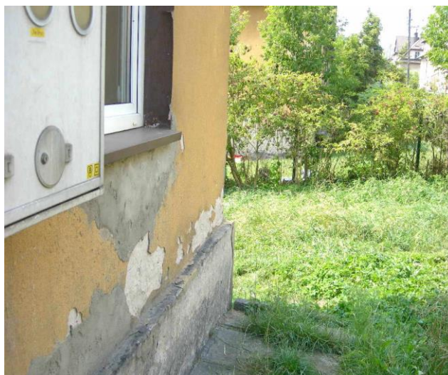
Zawilgocenie na wysokości 1,60m
