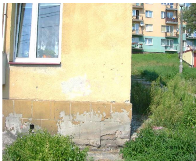
Zawilgocenie na wysokości 1,60m
