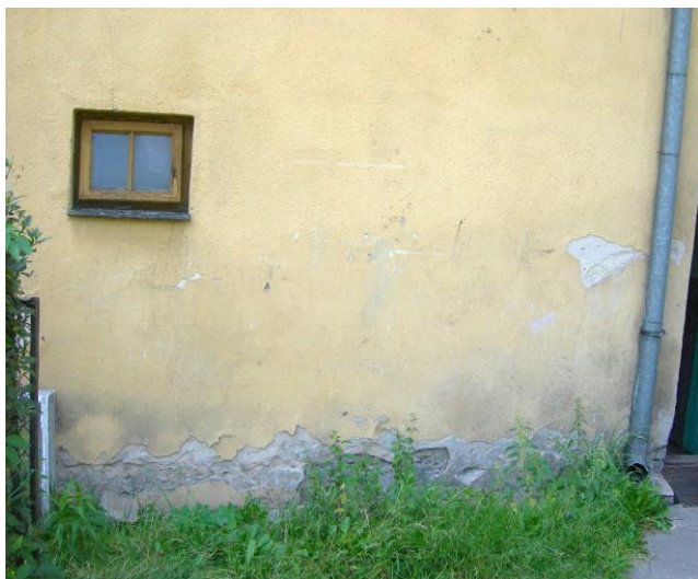
Zawilgocenie na wysokości ok. 1,60m
