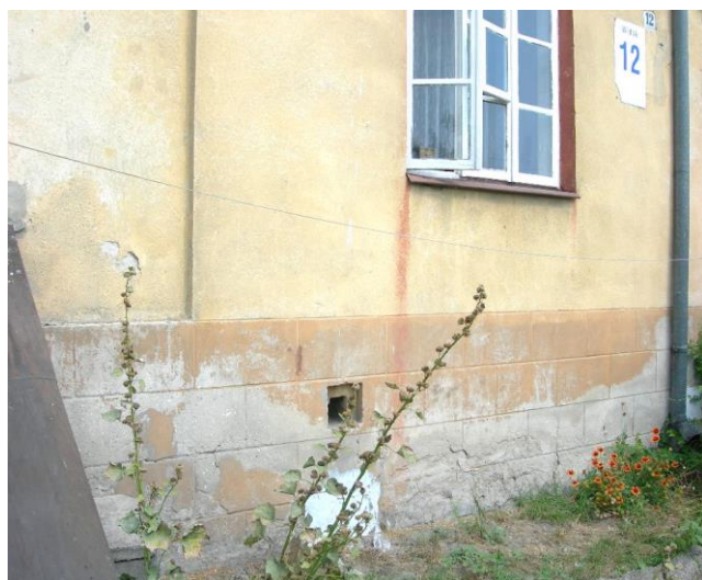
Zawilgocenie na wysokości 0,70m
