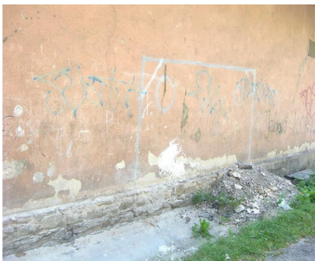
Zawilgocenie na wysokości 1,10m
