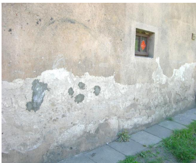
Zawilgocenie na wysokości ok. 2,10m
