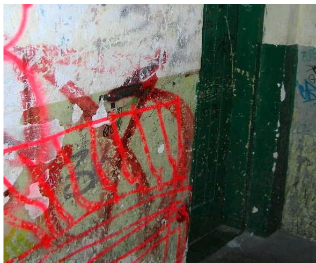
Zawilgocenie na wysokości 1,30m
