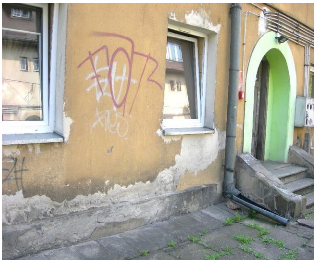
Zawilgocenie na wysokości 2,70m
