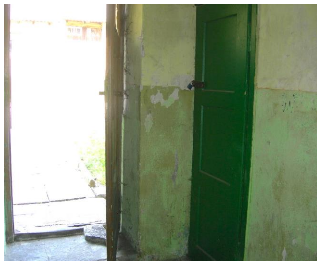
Zawilgocenie na wysokości ok. 1,70m
