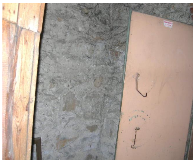
Zawilgocenie na wysokości ok. 1,60m
