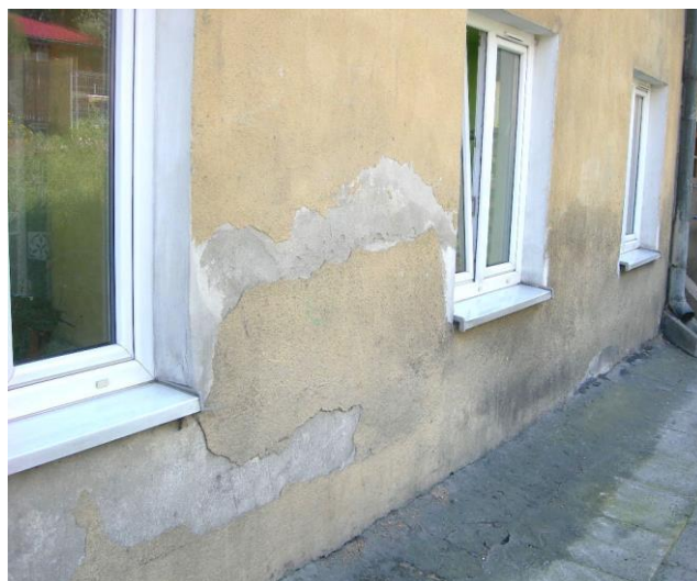
Zawilgocenie na wysokości 2,20m
