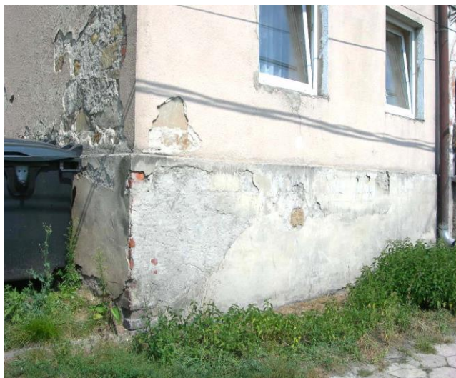
Zawilgocenie na wysokości 1,00m
