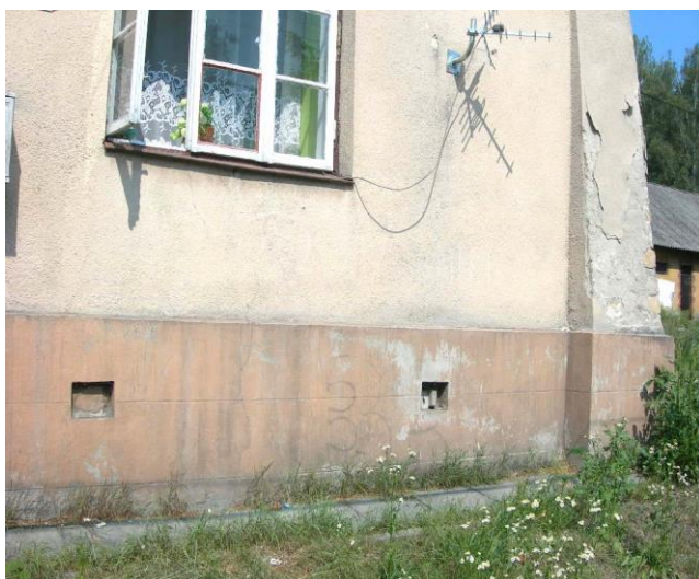
Zawilgocenie na wysokości 2,30m
