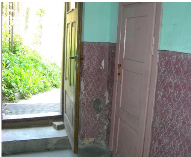
Zawilgocenie na wysokości ok. 2,20m
