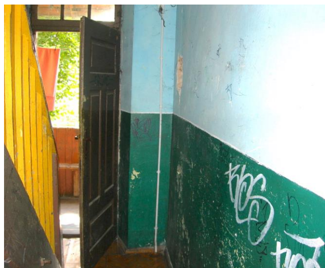
Zawilgocenie na wysokości ok. 1,50m
