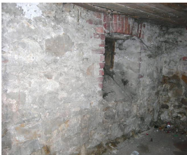
Zawilgocenie na wysokości ok. 1,70m
