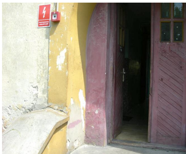
Zawilgocenie na wysokości 2,10m
