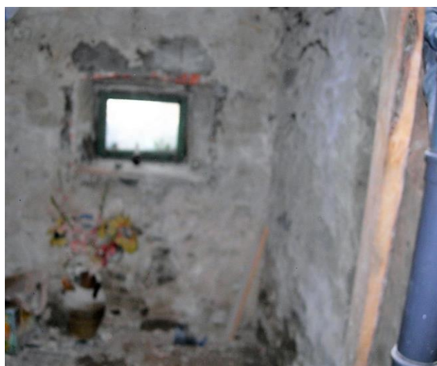
Zawilgocenie na wysokości ok. 1,90m
